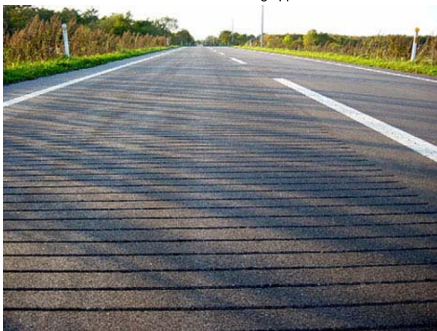
L'immagine mostra le scanalature sul manto stradale che consentono la riproduzione di suoni.
